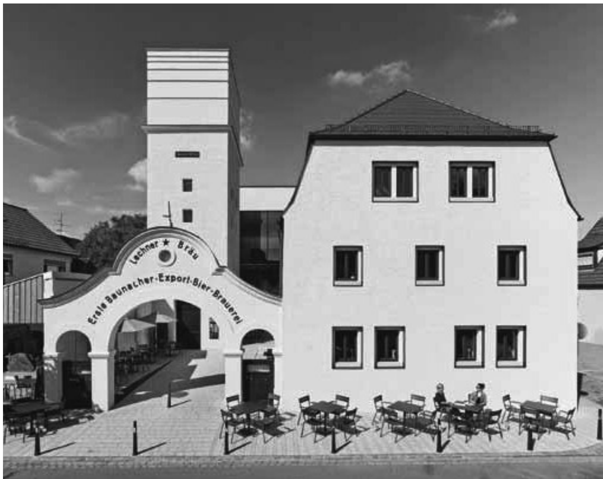
Abb. 3: Frontansicht des Bürgerhauses Baunach im Eröffnungsjahr 2013.
